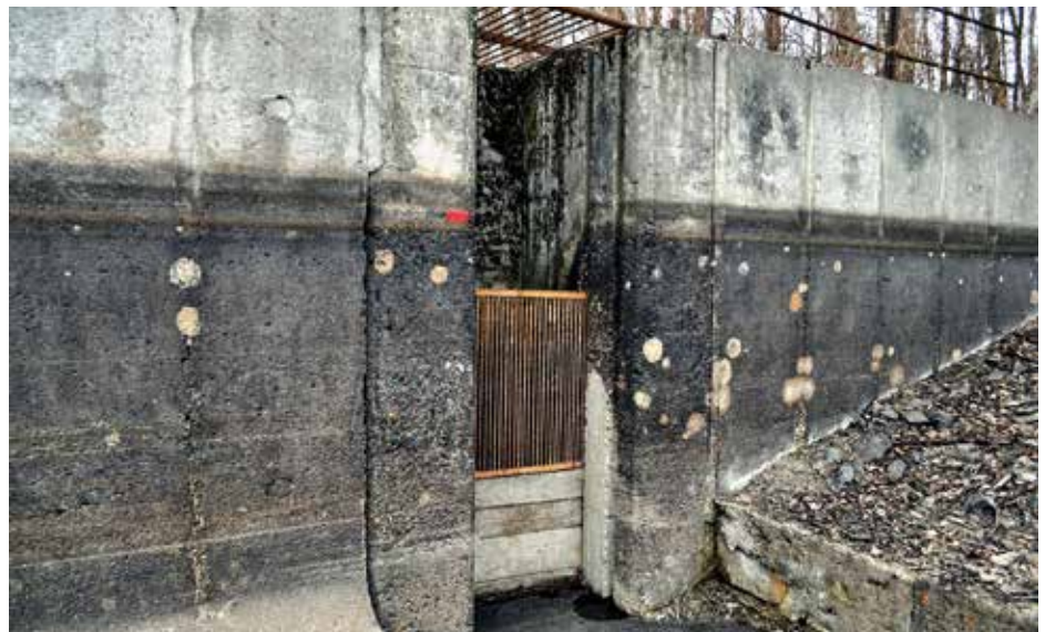
Ablassbauwerk (Ständerbauweise) eines Karpfenteiches
